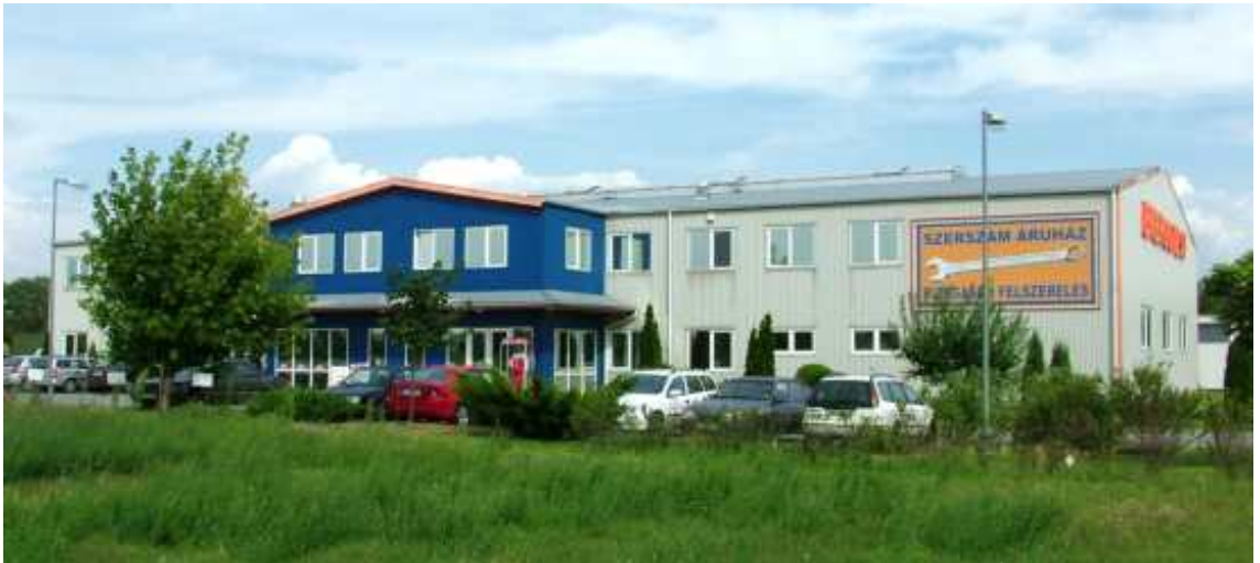
Hauptsitz ENERGO TEST in Dunaharaszti, Ungarn
